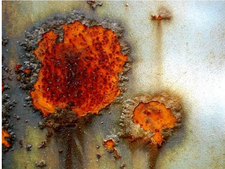
Fot. 8. Korozja metalu – rdza
