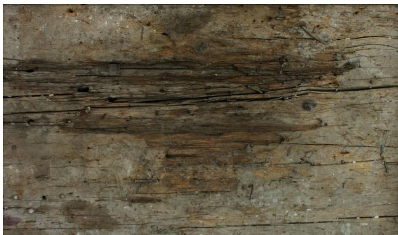
Fot. 10. Drewno niszczące pod wpływem działania wody, gliny, gipsu
