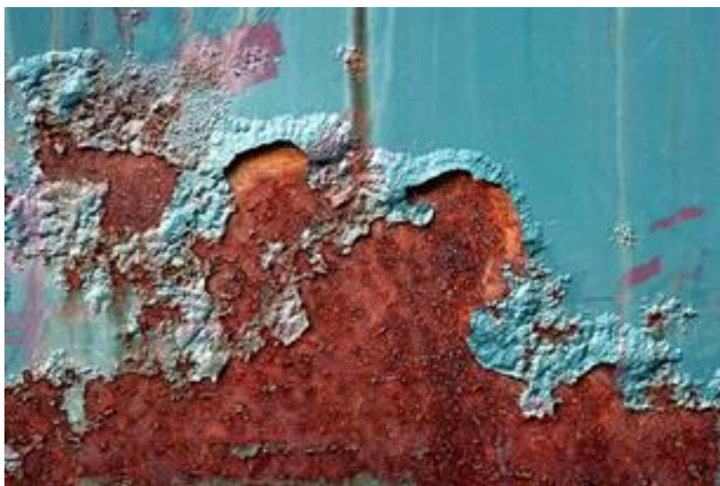
Fot. 7. Korozja metalu – rdza
